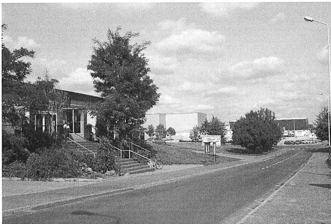
Fot. 2. Teren inwestycji – widok wzdłuż ul. Mieszka I od południa
