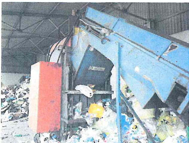
Fot. Nr 3 – widok ogólny;
