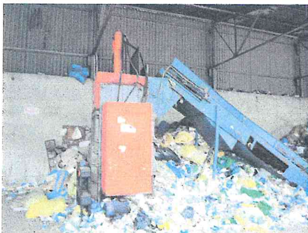
Fot. Nr 1 – widok ogólny;
