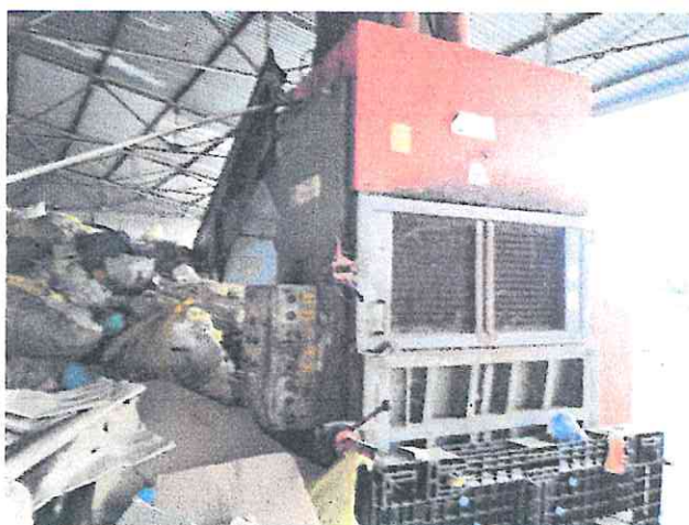
Fot. Nr 2 – widok ogólny;
