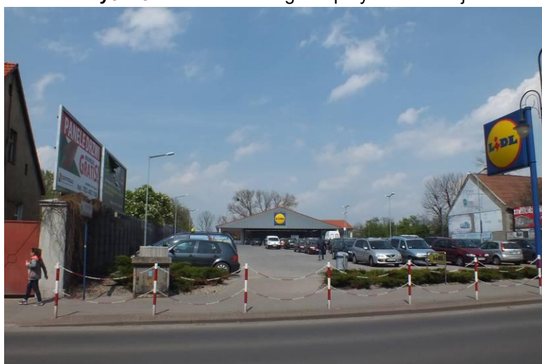
Ryc. 16. Zabudowa usługowa przy ul. Kaliskiej
