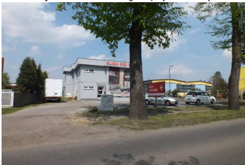
Ryc. 15. Zabudowa usługowa przy ul. Kaliskiej
