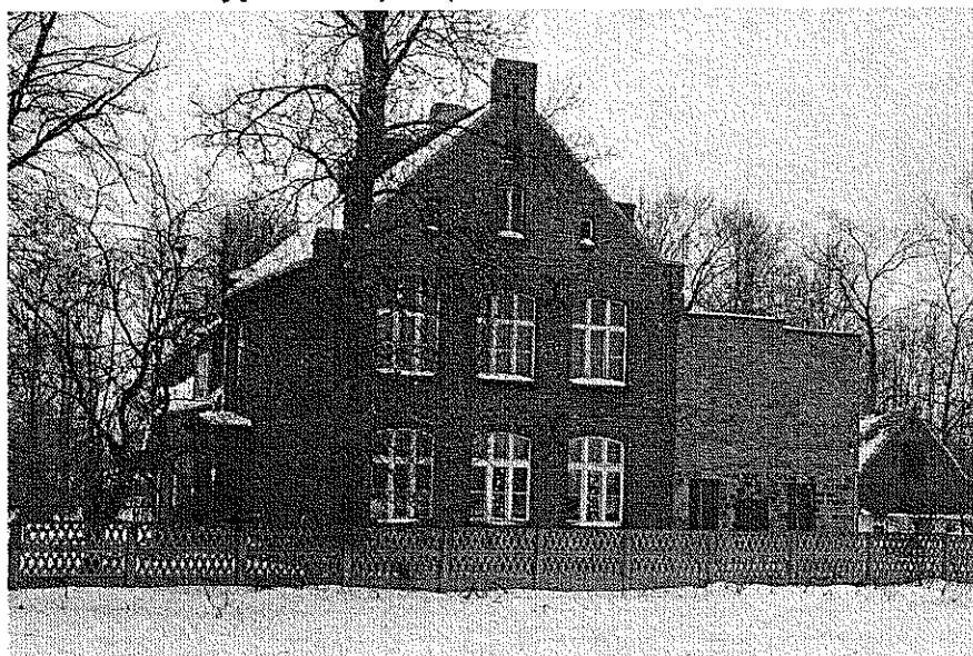
Zdjęcie 2. Budynek przedszkola w Piekarzewie.
