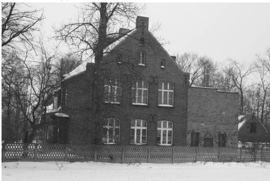
Zdjęcie 2. Budynek przedszkola w Piekarzewie.
