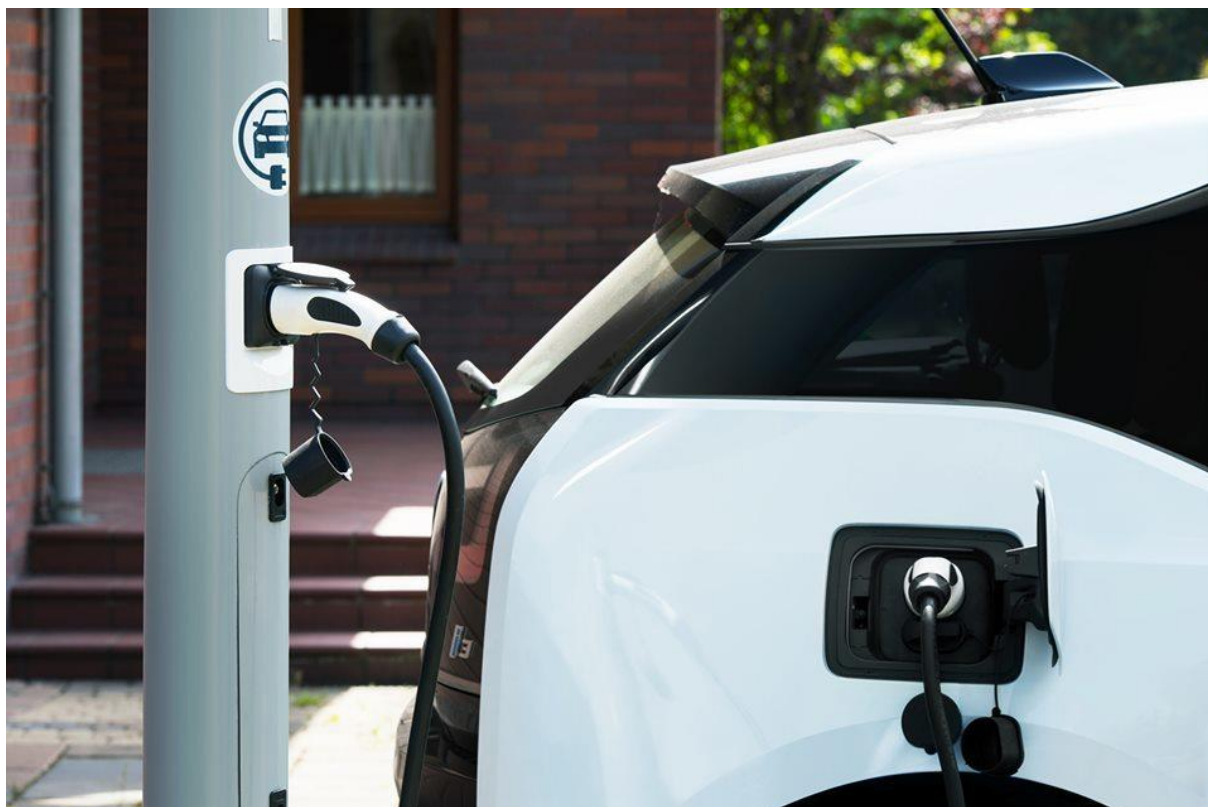
Rysunek 25. Przykład stacji ładowania samochodu elektrycznego zamontowanego w lampie oświetleniowej
