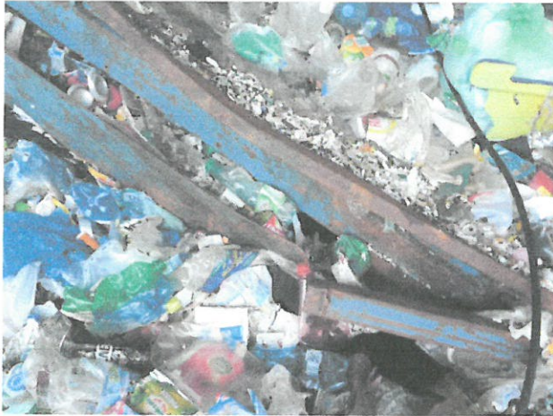
Fot. Nr 5 – uszkodzenia podajnika;
