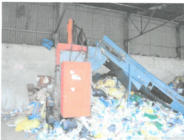
Fot. Nr 1 – widok ogólny;
