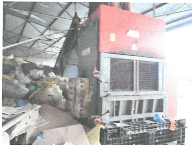
Fot. Nr 2 – widok ogólny;
