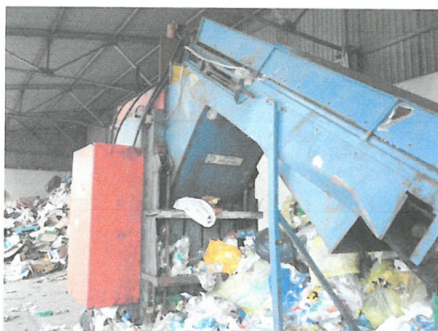
Fot. Nr 3 – widok ogólny;
