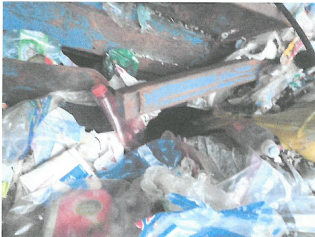
Fot. Nr 6 – uszkodzenia ramy podajnika;
