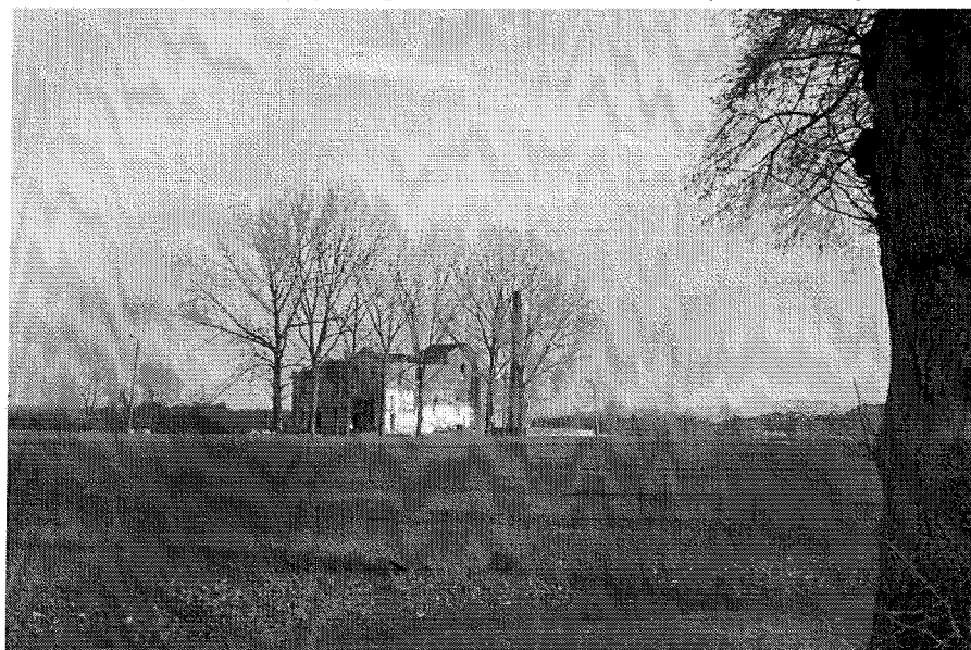
Zdjęcie 2. Budynek gorzelnii – widok od strony zachodniej
