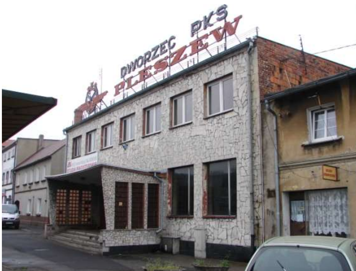
Fot. 3. Istniejący budynek byłego dworca PKS – do rozbiórki
