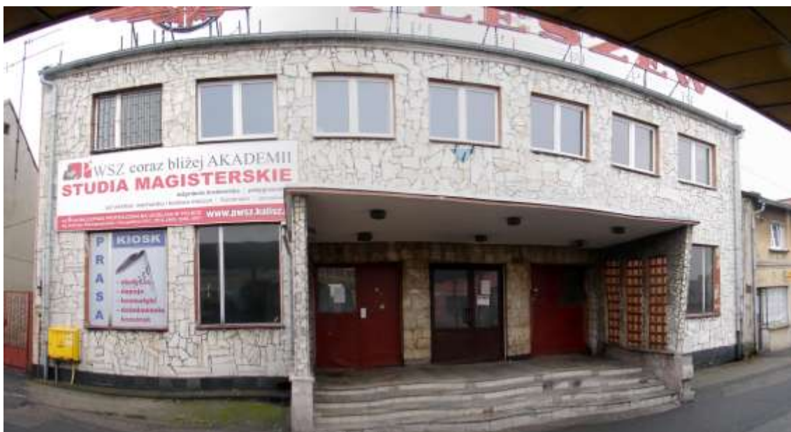
Fot. 2. Istniejący budynek byłego dworca PKS – do rozbiórki
