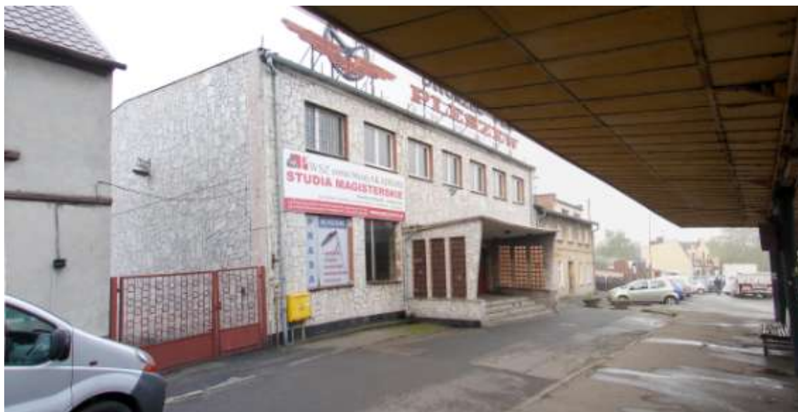
Fot. 1. Panorama terenu inwestycji od północnego wschodu
