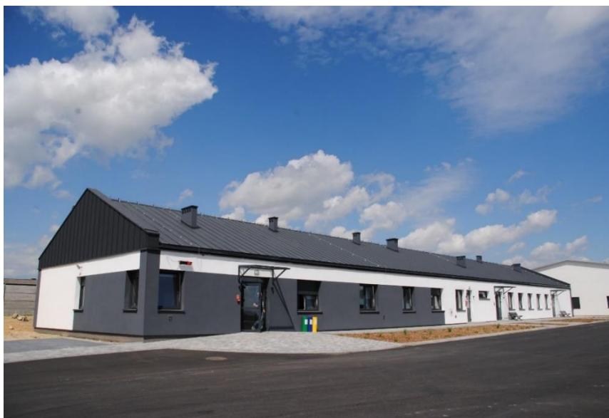
Zdjęcie 23. Budynek biurowo – socjalny przy ul. Polnej.
