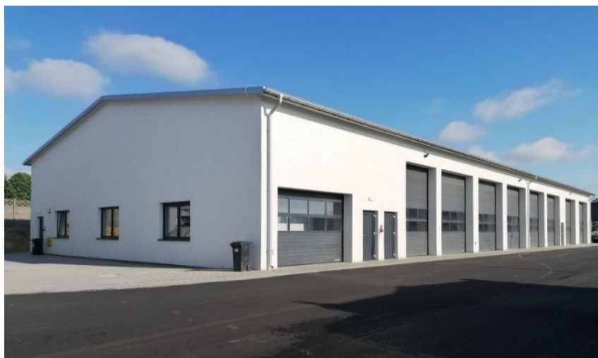
Zdjęcie 24. Budynek garażowy przy ul. Polnej.
