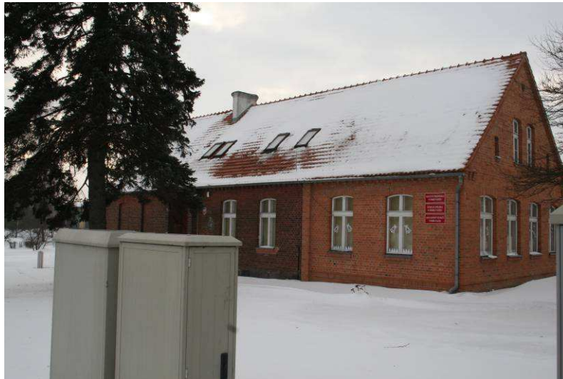
Zdjęcie 1. Budynek przedszkola w Dobrej Nadziei.
