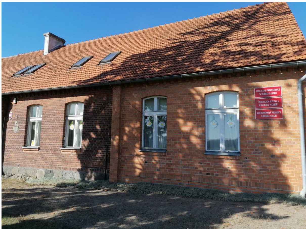
Fot. Nr 3. Okna wg zapytania strona wschodnia : z pkt. I.1. 4) 4 szt., 1,00m x 1,94m
